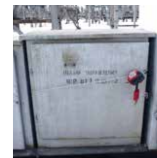
Запирание нестандартных шкафов, щитков и т.д., которые невозможно запереть замком
