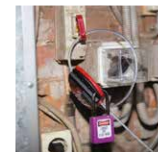
Одновременное запираение нескольких блокираторов любого типа
