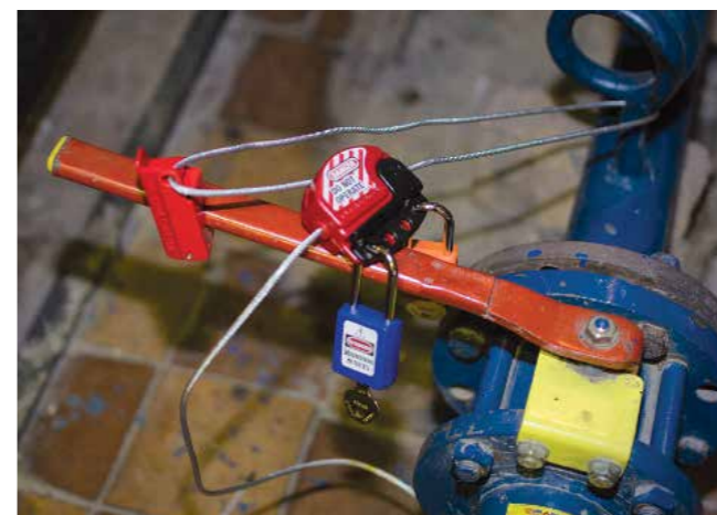
Блокировка шаровых кранов совместно с блокиратором 493В или 491В
