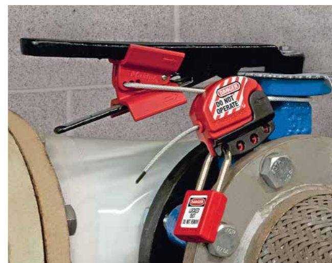
Фиксация вставки S3920 при блокировке дисковых поворотных затворов
